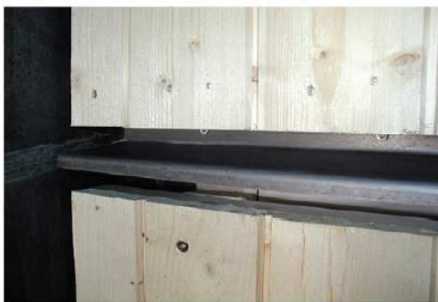
Risba 3: Primer zaščite, ki določen čas preprečuje ver- tikalni prenos požara po leseni fasadi (Vir: FASSADEN AUS HOLZ, GVZ)
